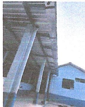
Foto 2: Sustitución de lámina en área de aulas
