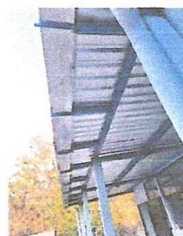
Foto 4: Mantenimiento a estructura metálica en el área de las aulas (lijado y pintura).
